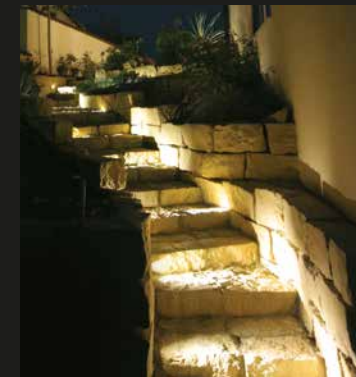
Treppenbeleuchtung, Superspot-Mini 20° HL-LED
