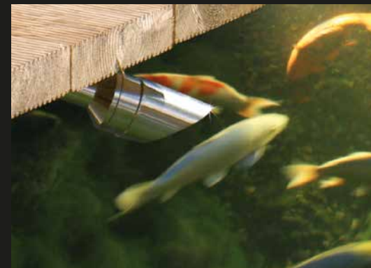
Teichbeleuchtung über der Wasserfläche: Leuchtenhalter 50 mm mit Edelstahldübel unter Holzdeck montiert
